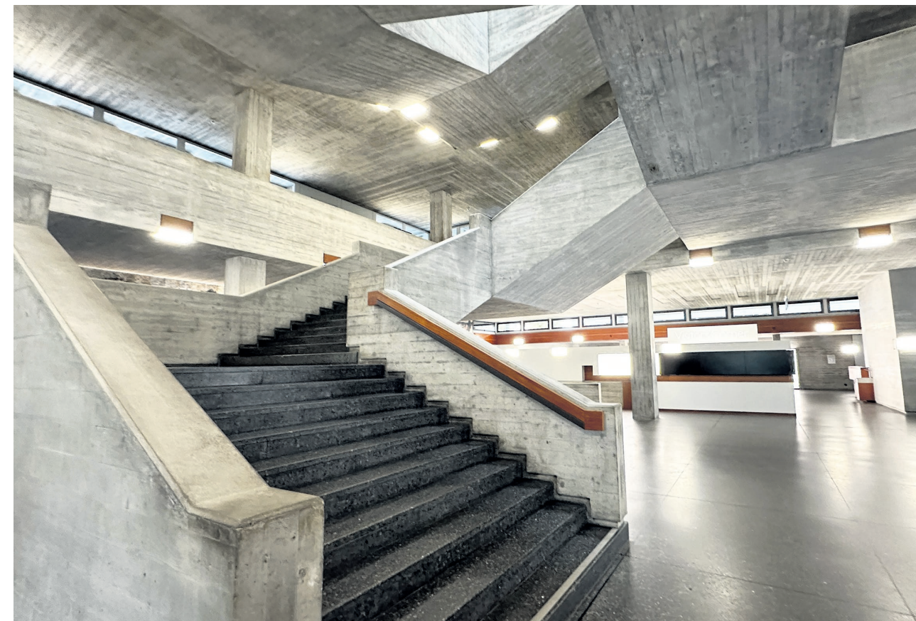
Anlaufpunkt für Architekten aus aller Welt ist immer noch die freitragende Betontreppe im Hauptgebäude.
