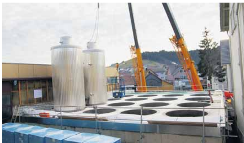
Insgesamt wurden 16 Gär- und Lagertanks installiert.
