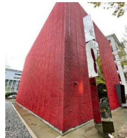
Allein das Gebäude der Fondazione Ghisla Art Collection von Moro & Moro ist bereits sehenswert.
